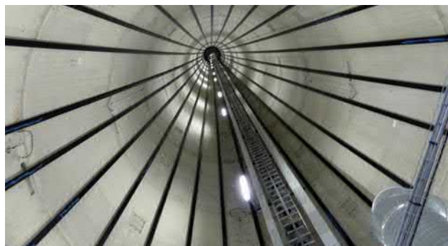
Abbildung 4.5-2: Blick ins Innere der Anlage mit 143 m Nabenhöhe. Foto: LUBW
