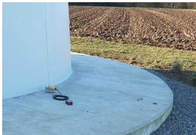
Abbildung 4.8-1: Erschütterungs-Messpunkt MP A am Turmfundament der WEA 5. Foto: Fa. Wölfel
